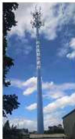
杭州铁路公司通讯基站改造
