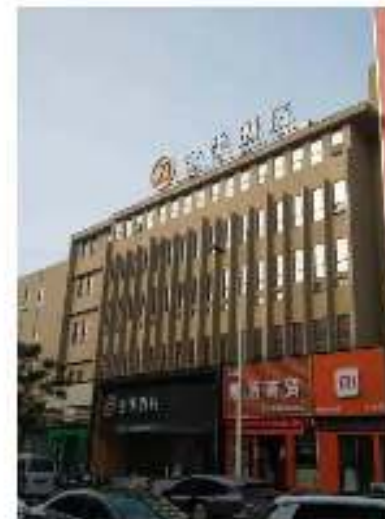
洛阳全季酒店空调节电改造
